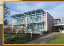
C Oberstufe Neubau
